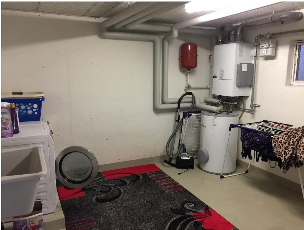
Waschküchenraum mit Heizung und Wasser- bzw. Elektroverteilung
