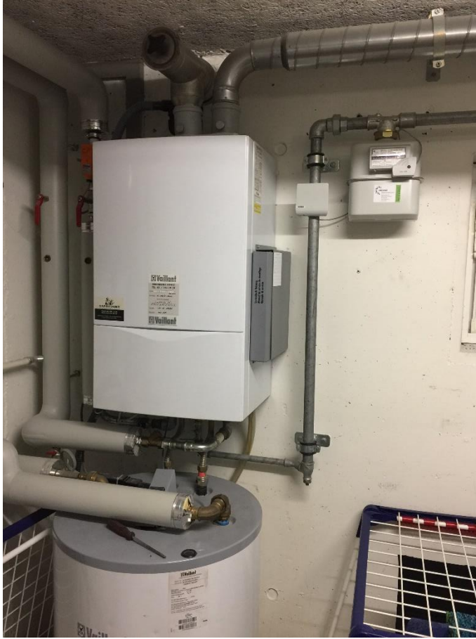
Gasheizung Vaillant 27kW; Bodenheizung in allen Räumen
